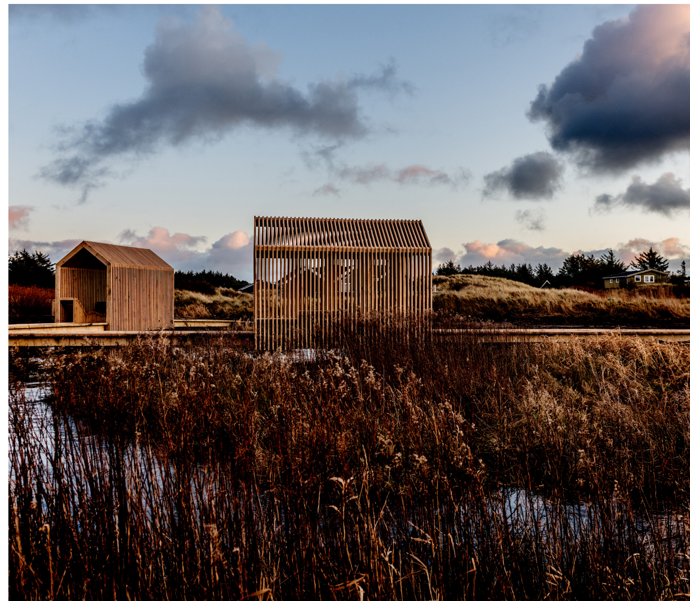
Brodæk og opholdsrum kan ikke bare skabe tilgængelighed i våde områder, det kan også blive arkitektoniske markører i landskabet / Foreningsstien, Klitmøller / LABLAND architects
